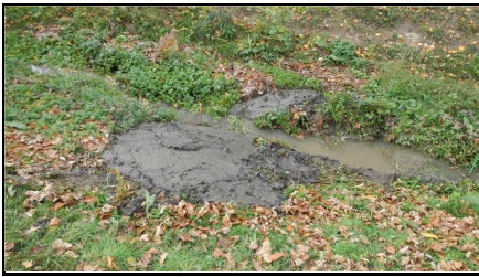
Abb. 3: während Bau Versuchs-Kieslaichplatz MS6, 08.11.2018
