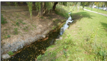
Abb. 1: Vor der Maßnahme: fehlende Unterstände für Fische, 28.09.2017
